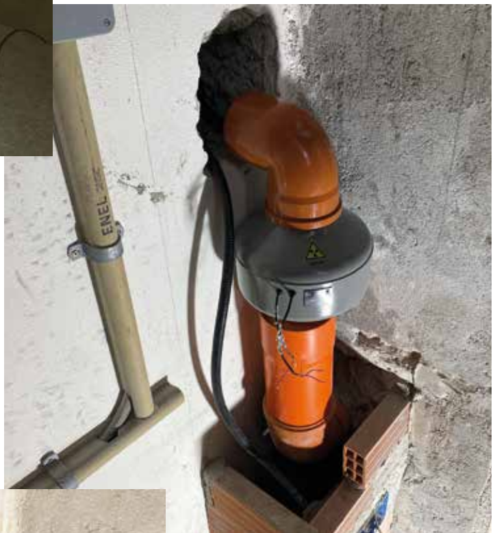
Installazione centralina SICURBOX di controllo, monitoraggio e gestione.
